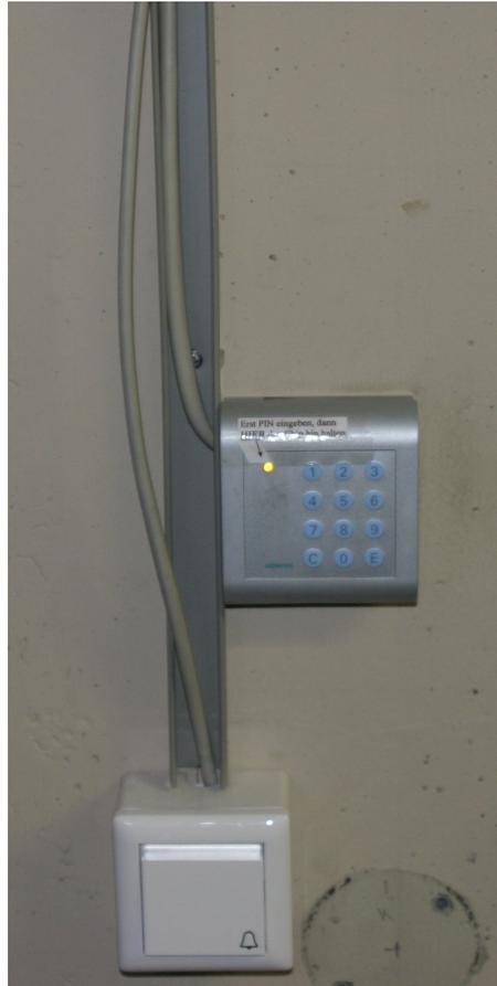
Abbildung 4.3: Leser mit integriertem PIN-Pad und geöffnetem Kabelkanal
