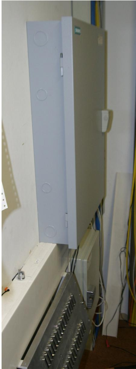
Abbildung 4.4: MBOX (unten) und in Switchbox integrierte VPN-Box (oben)
